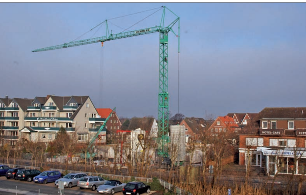
Die Bauarbeiten für den Neubau an der Hohenzollernstraße, direkt hinterm Deich, haben begonnen. Fotos: Brumm
